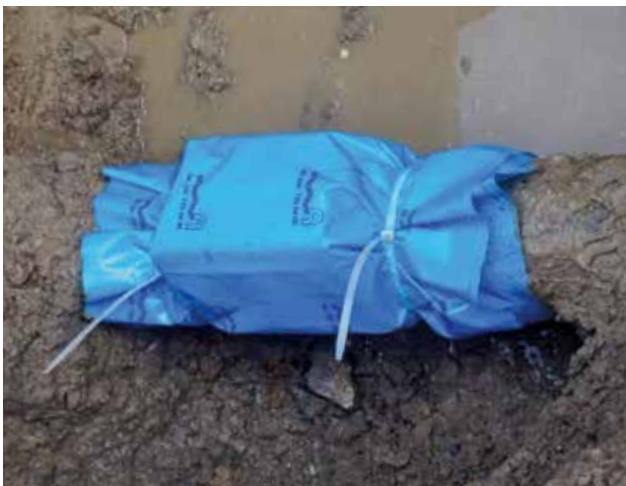
Reparatur einer Gussleitung mit RepaFlex® 22, isoliert.
