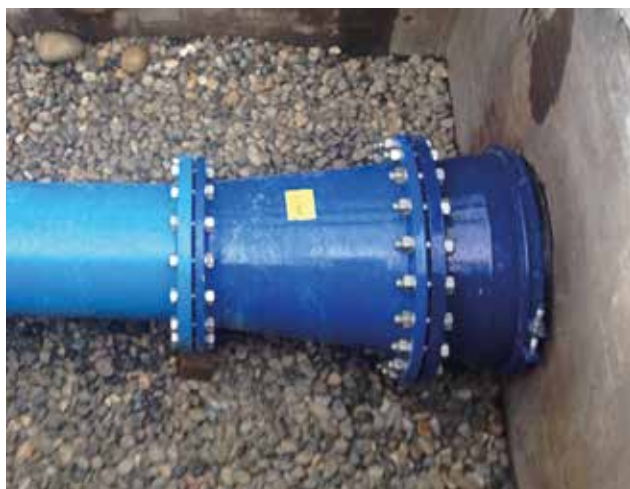
Einbau Hymax® Flansch DN 500.
