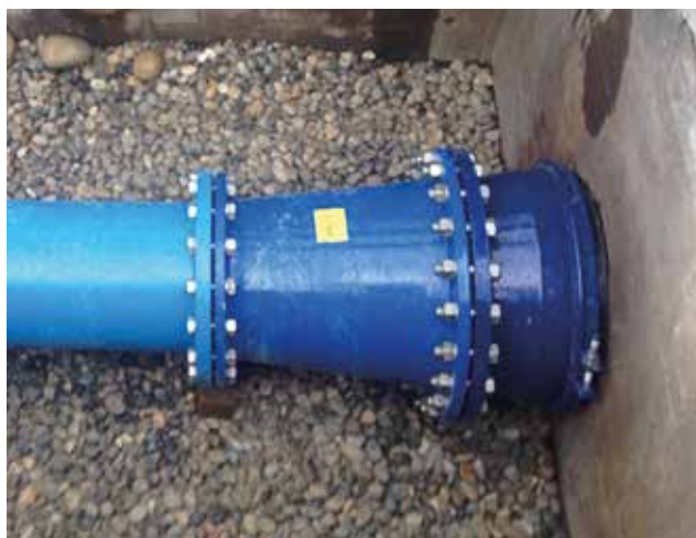
Einbau Hymax® Flansch DN 500.
