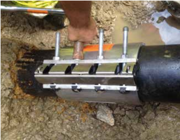
Reparatur einer Gussleitung mit RepaFlex® 22 Long.
