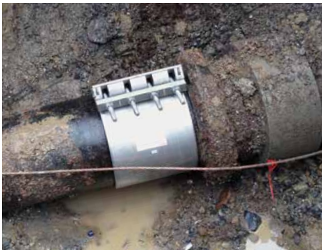
Die Praxis zeigt, ob ein Produkt hält, was es verspricht: Montagebeispiel RepaFlex® 22 Long 280 mm.
