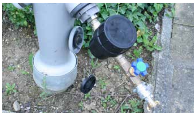
GALLO am Hydranten mit PE-Schutz für Wasserzähler PMK
