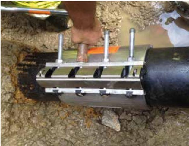
Reparatur einer Gussleitung mit RepaFlex® 22.
