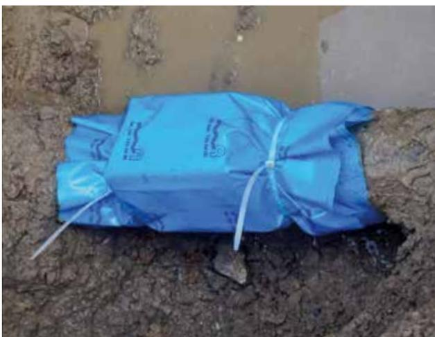
Reparatur einer Gussleitung mit RepaFlex® 22, isoliert.
