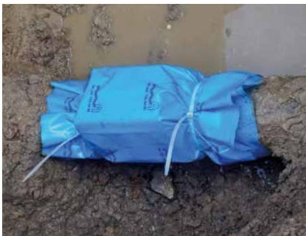
Reparatur einer Gussleitung mit RepaFlex® 22, isoliert.
