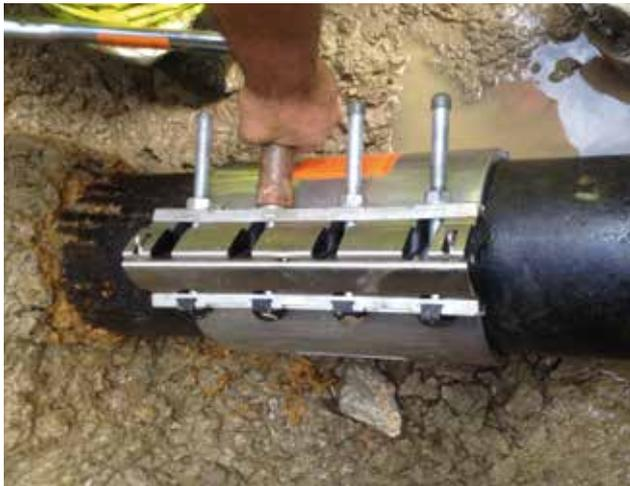
Reparatur einer Gussleitung mit RepaFlex® 22.
