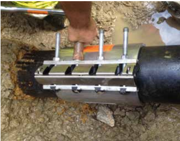
Réparation d'un tuyau en fonte avec RepaFlex® 22..
