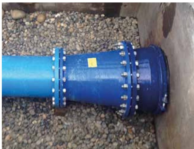
Montage d'une Hymax® bride DN 500.
