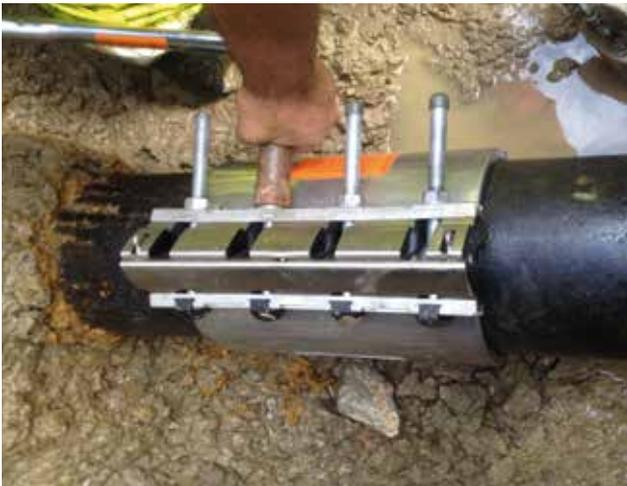
Réparation d'un tuyau en fonte avec RepaFlex® 22..
