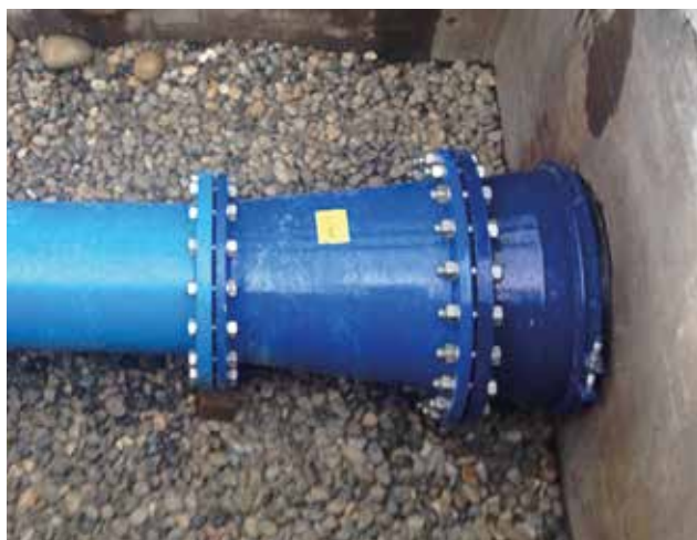
Montage d'une Hymax® bride DN 500.
