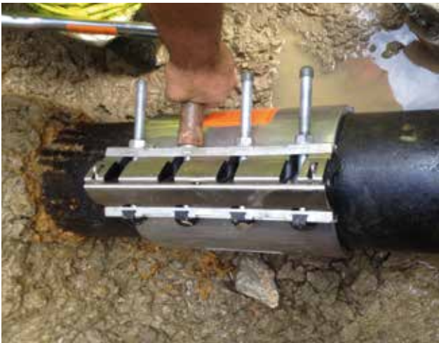
Réparation d'un tuyau en fonte avec RepaFlex® 22..
