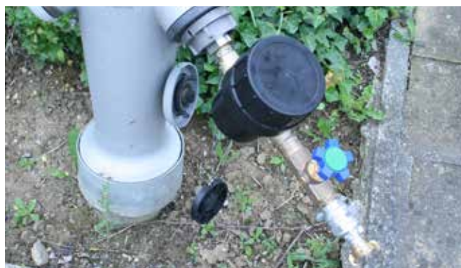
GALLO à la borne hydrante avec protection en PE pour le compteur d'eau PMK
