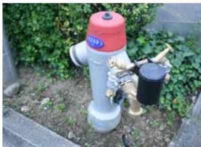
Exemples avec GALLO (à gauche) et CERVO (à droite) avec protections pour compteurs d'eau
