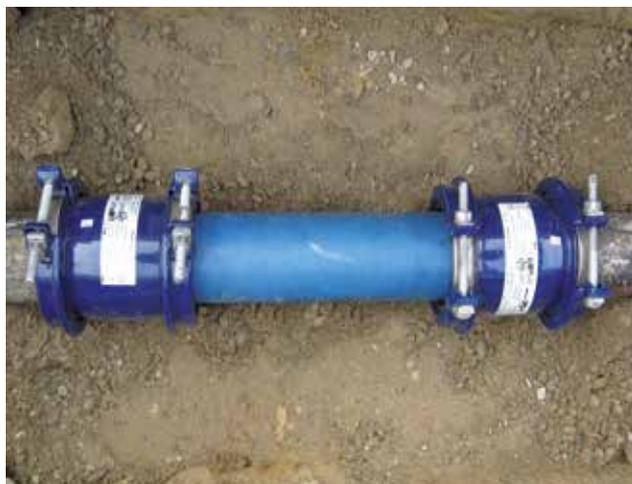
Réparation avec deux Hymax® et un tuyau court. Montage très simple d'en haut avec 2 vis d'accès facile par raccordement.
