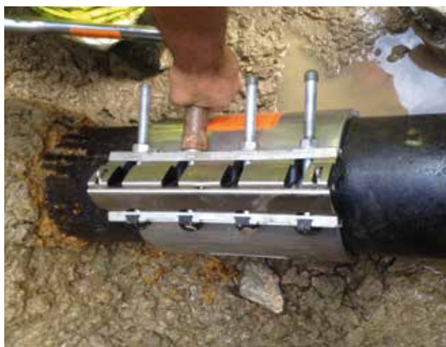
Riparazione di un tubo in ghisa con RepaFlex® 22.
