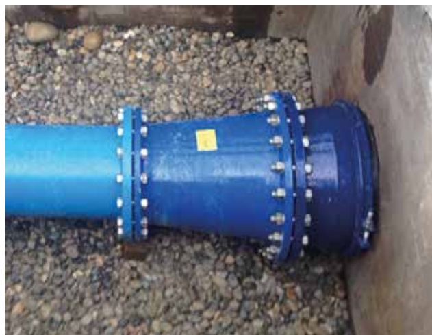
Montaggio di una Hymax® flangia DN 500.
