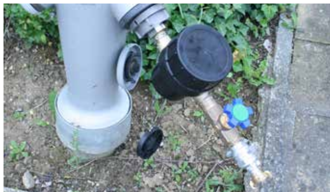
GALLO all'idrante con protezione in PE per contatore d'acqua PMK
