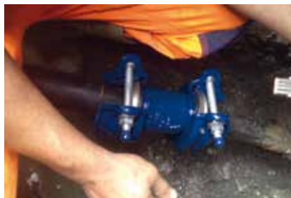
Montaggio rapido con avvitatrice a impulso.
